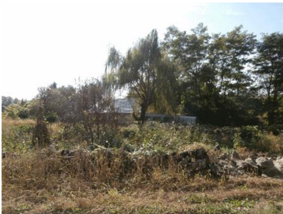
Fotografia 3. Degradacja stanu obiektów budowlanych i przestrzeni publicznej w Prusach
