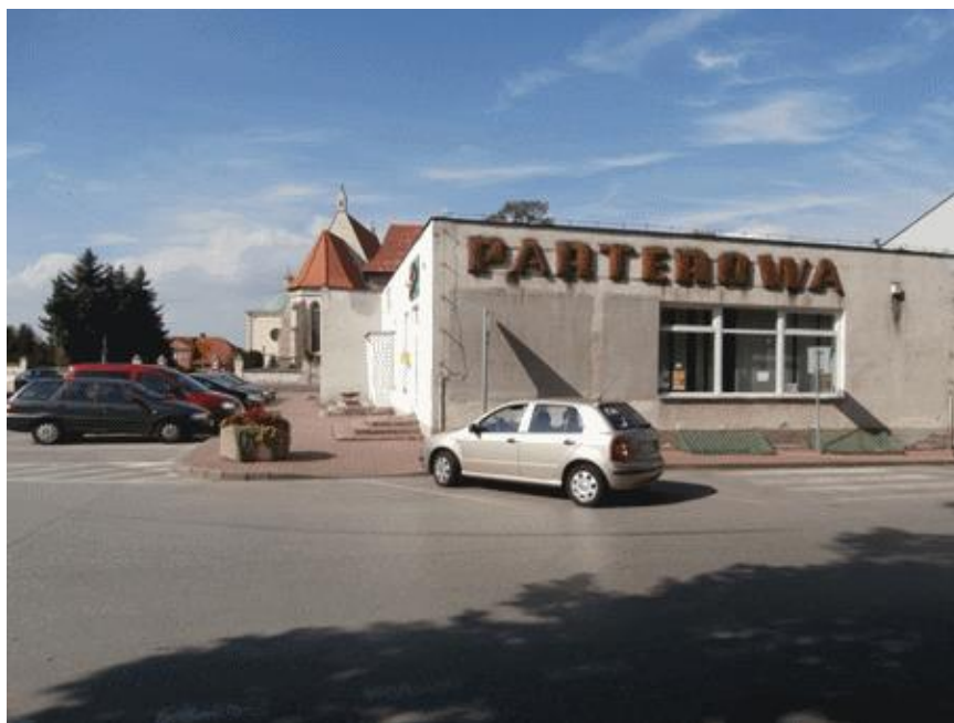
Fotografia 7. Elementy zakłócające przestrzeń architektoniczną w historycznej części Stopnicy
