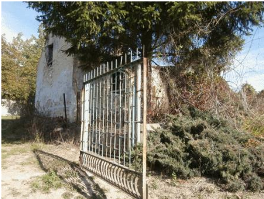
Fotografia 2. Degradacja stanu obiektów budowlanych i przestrzeni publicznej w Prusach
